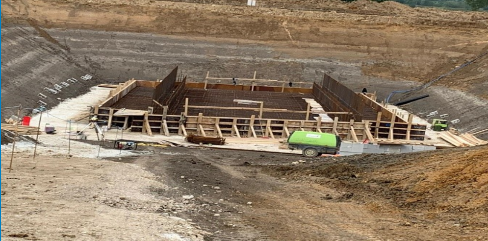
Before the concrete pour
