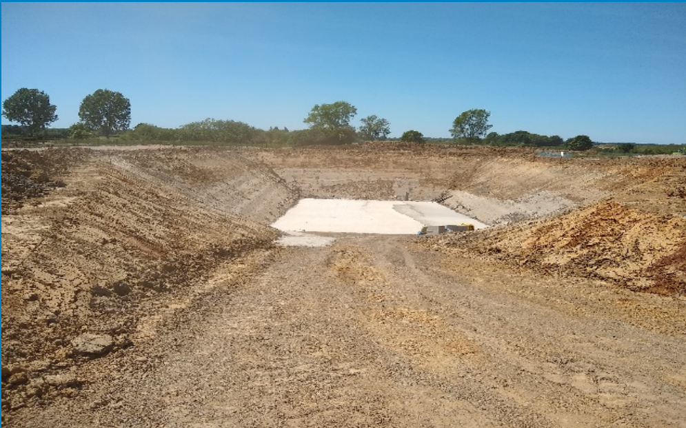
After the concrete pour
